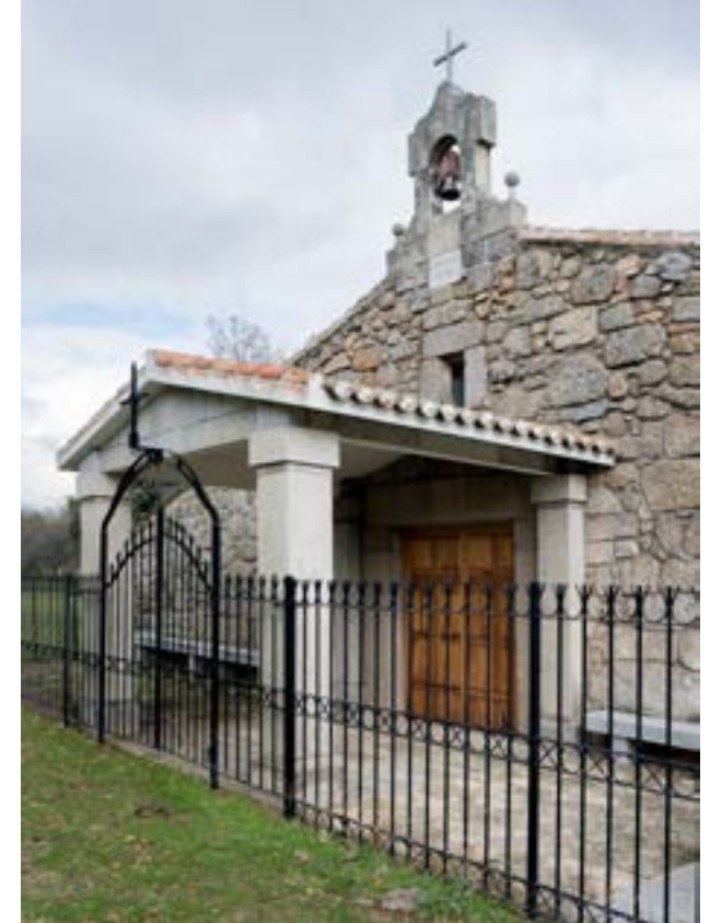
Fachada de la ermita de San Miguel Arcángel, Navalagamella
