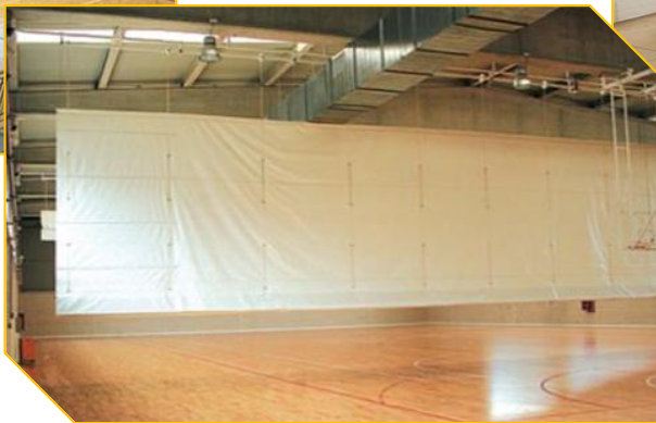
Cortina separadora de acondicionamiento eléctrico instalada en el techo del gimnasio.
